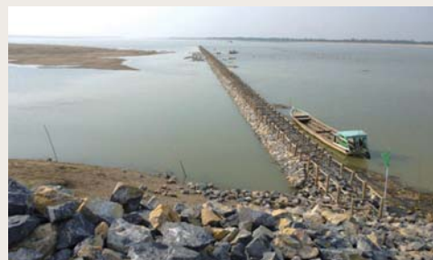
エーヤワディー川に設置された水制 Spur dyke constructed in Ayeyarwady river
