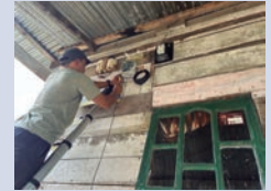
大気汚染計測機器のメンテナンスの様子 Maintenance of air pollution measurement equipment
